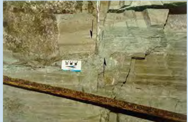
Рис. 7. Разрывное нарушение сбросового типа, зафиксированное в подземных горных выработках
