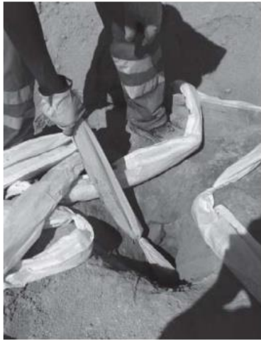
Рис. 1. Один из этапов заряжания контурного ряда скважин
